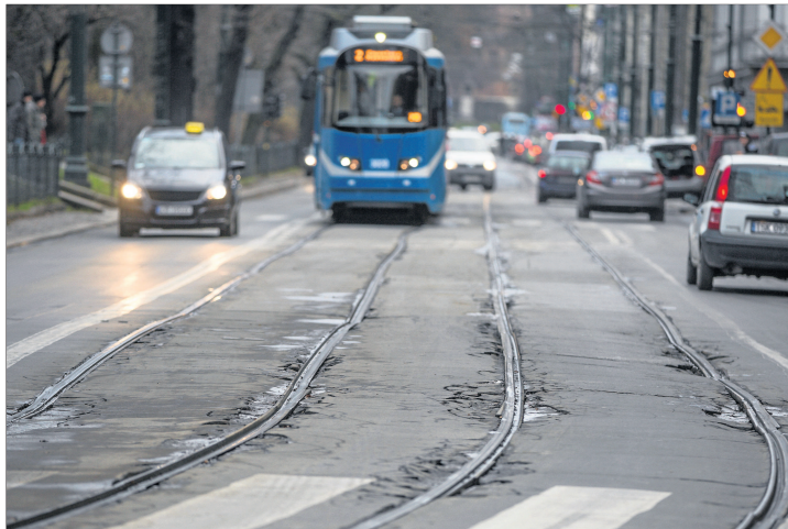
Szyny wokół Plant są w tak fatalnym stanie, że tramwaje muszą zwalniać, aby bezpiecznie przejechać
